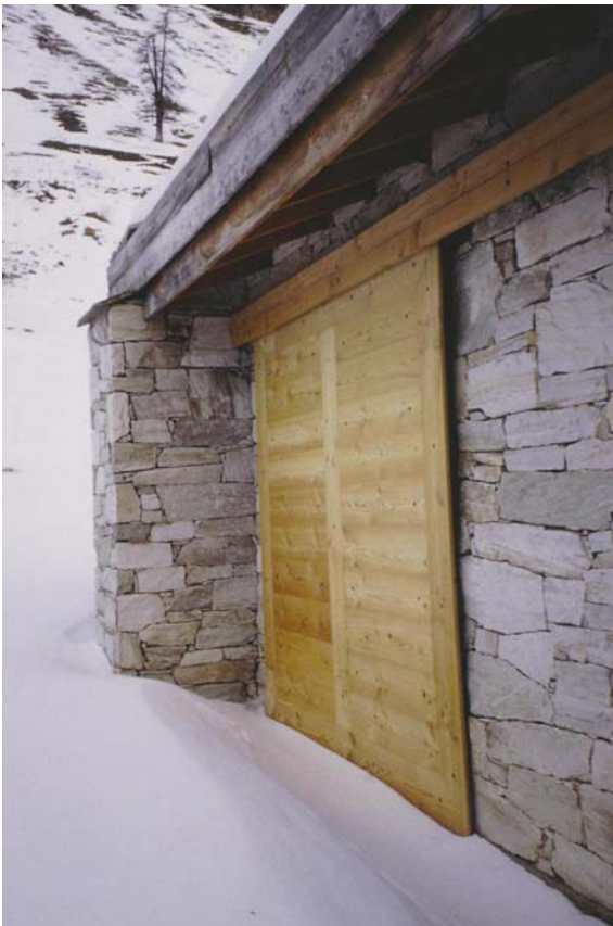
Photo 7-20. Val d'Isère panneau coulissant bois renforcé par une tôle à l'intérieur
