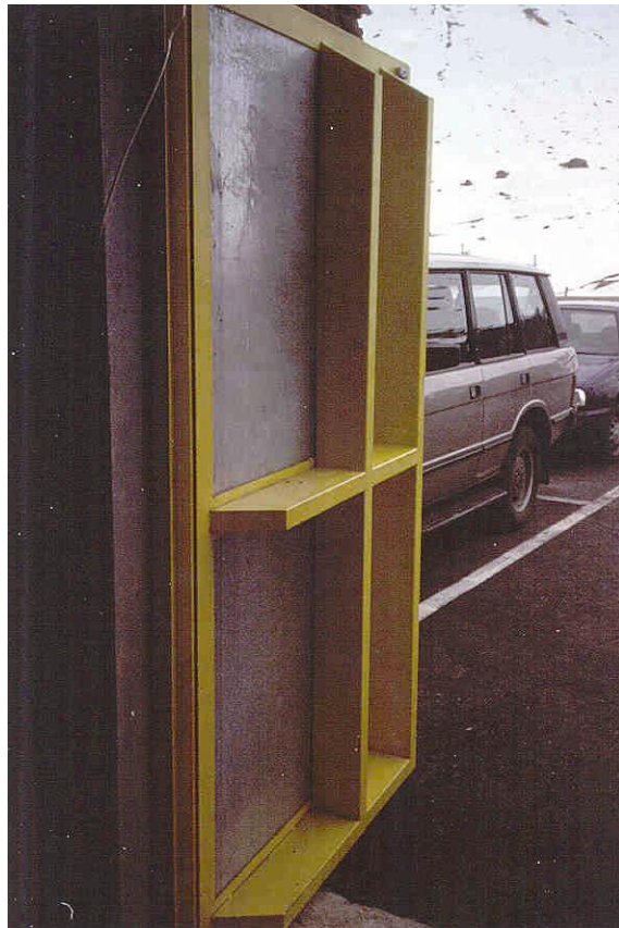
Photo 7-21. Gare du Pic du Midi à la Mongie une porte résistant à 10 kPa (1 t/m 2 )
